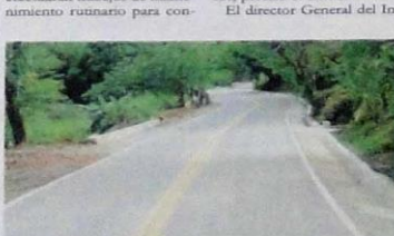
La vía que se está pavimentando es una de las más importantes del Tolima.
